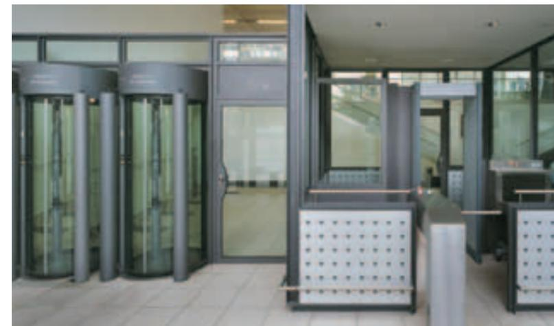
Um den Personenfluss zu steuern, wird ein **SITEC Drehkreuz** eingesetzt. Ein **Metalldetektor** sowie ein **Röntgenprüfgerät** verhindern das Einschleusen gefährlicher Gegenstände. Kinderwagen und Personen mit Behinderung gelangen durch eine vom Pförtner **gesteuerte Sicherheitstür** in den Innenbereich des Justizgebäudes.
