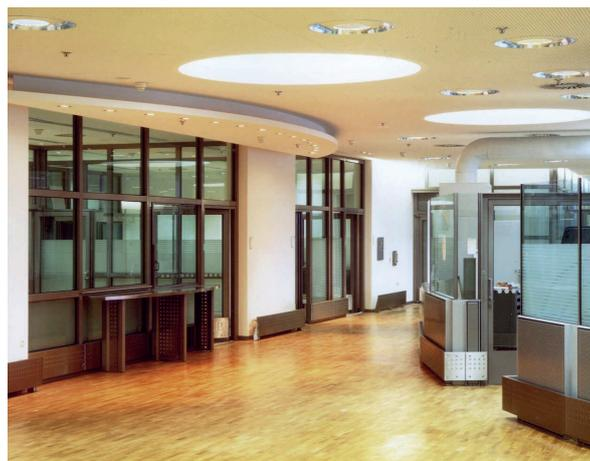
Ungesicherter Bereich mit freistehenden und veresetzbaren Trennwänden.
