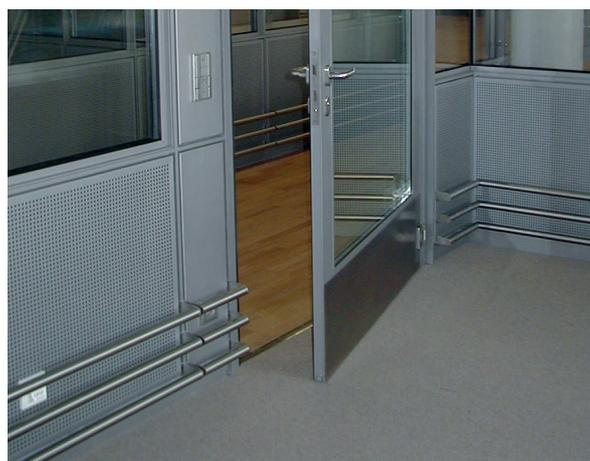
Gesicherter Bereich mit einbruch- und beschusshemmenden Trennwänden.
