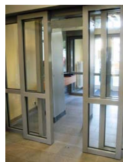
Einbaubeispiel – Schiebetür öffnet
